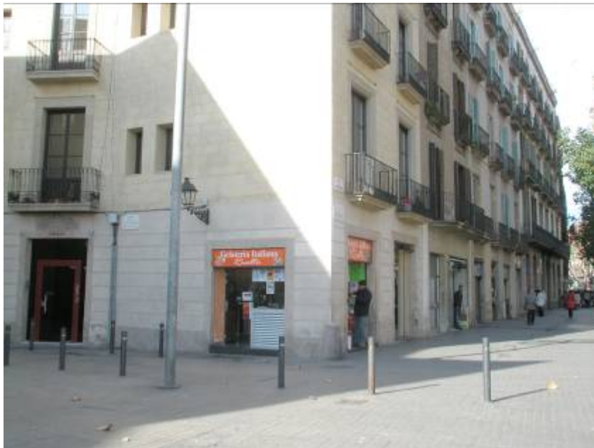
Carrer de Santa Mònica cantonada La Rambla
